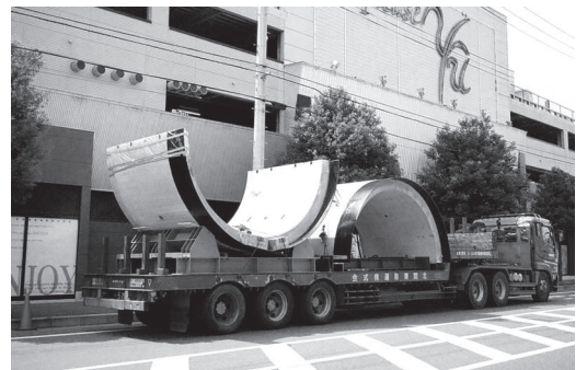
写真－7 組立式超大口径推進管φ3500×2300L運搬状況
