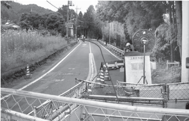
写真－３ 施工現場状況
