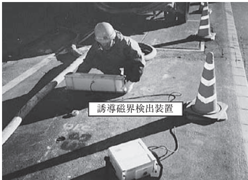
写真ー１ 電磁法位置計測状況
