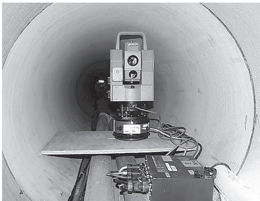
写真-1 管内設置状況
