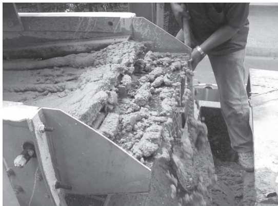
写真一八 残土処理状況 砂
