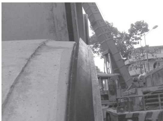
写真－16 推進管 接合部
