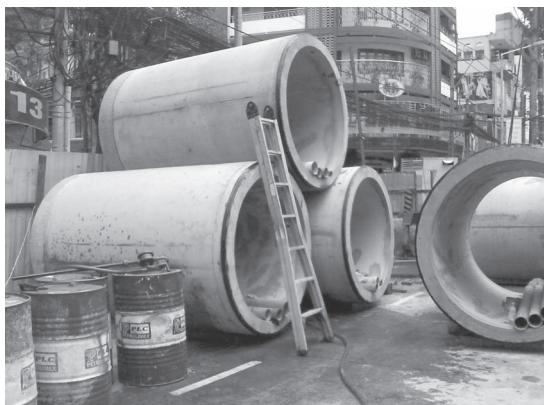
写真－15 推進管 全景
