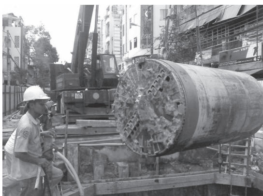
写真－12 掘進機 撤去・回収
