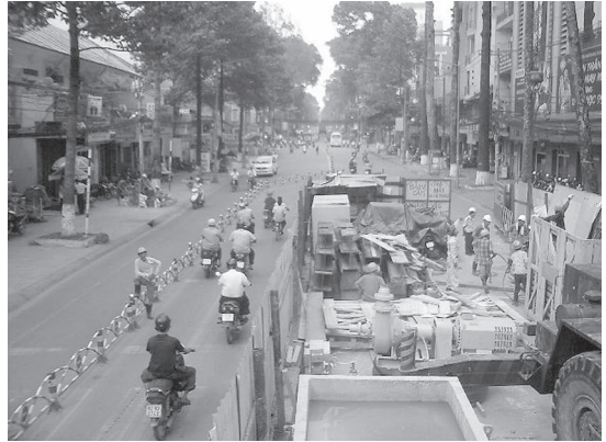
写真二 発進立坑（S14）より上流側（S13）を望む
