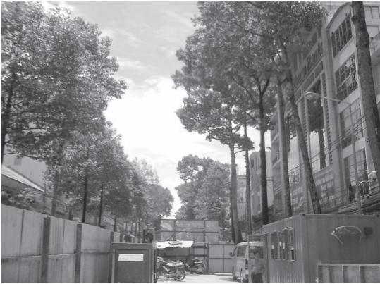
写真一 発進立坑（S14）付近の高木並木
