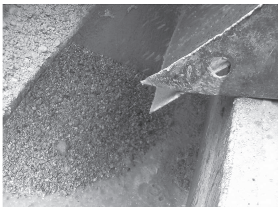
写真二〇 残土処理状況 小砂利
