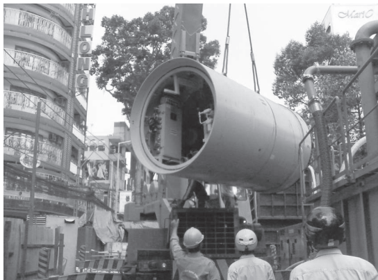
写真一七 掘進機 吊降ろし状況
