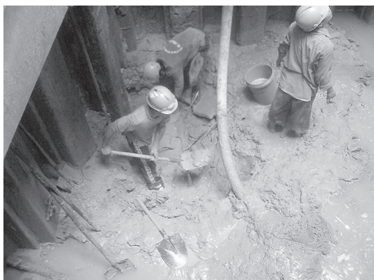
写真一6 発進立坑床掘再開
