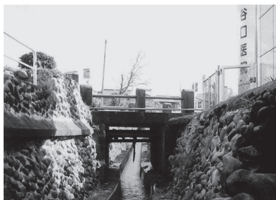
写真－9 下流側の水路
