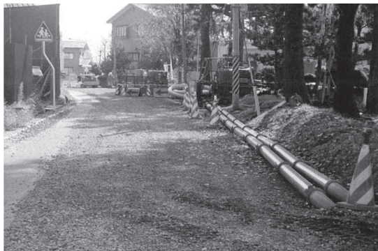
写真一五 砕石での応急復旧と仮配管
