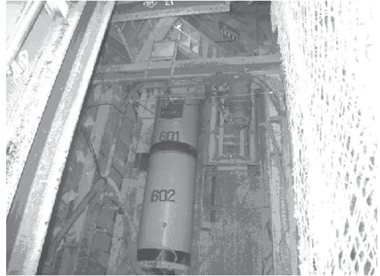
写真-3 2管推進用発進立坑・推進中
