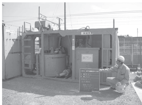
写真ー1 緩み土圧抑制材 注入プラント（プランジャポンプ）
