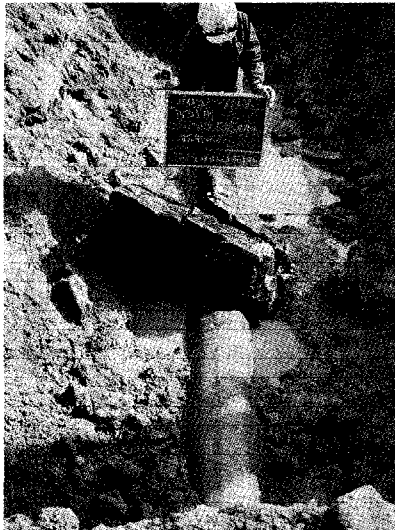
写真-3 ガイドボーリング工法 掘進実験での巨礫貫通状況 (φ800mmの巨礫を貫通した)
