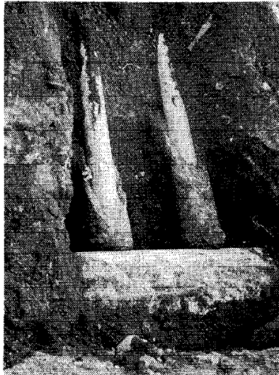
写真-4.4 セメントミルク充填状況
