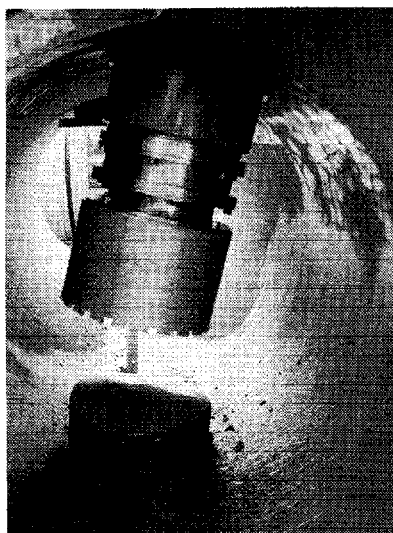
写真-6 穿孔状況
