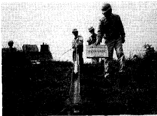
写真-3 掘進精度の管理実験
