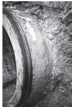
写真-2 マニキュア管の到達状況
