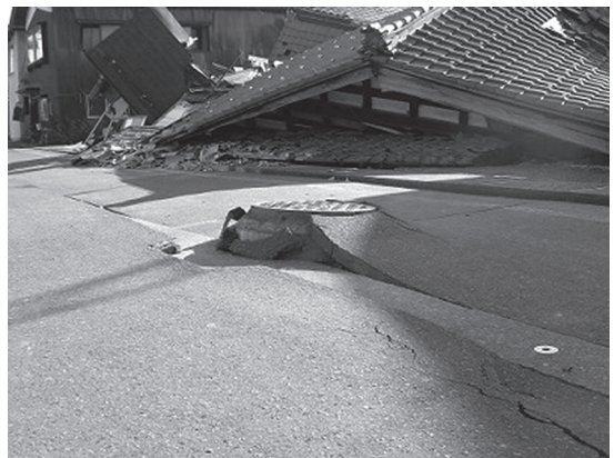
写真四 マンホール浮上被害状況（その3） ※4
