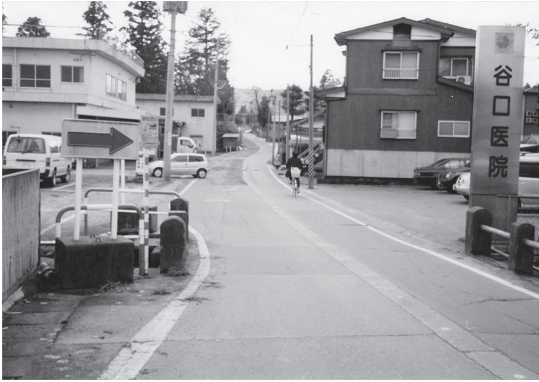
写真一5 推進区間から開削区間を見る ※5
