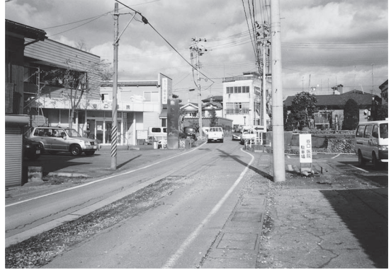
写真一6 開削区間から推進区間を見る ※6
