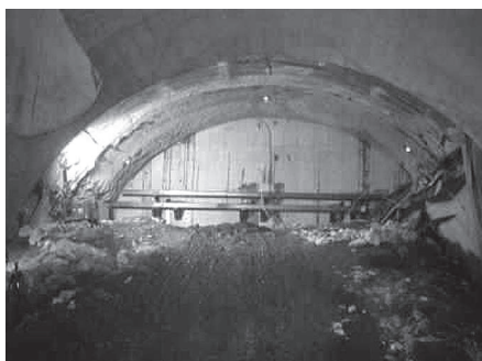
写真-11 本坑下半掘削
