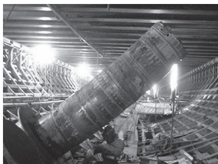
写真－18 曲線パイプルーフ推進機到達
