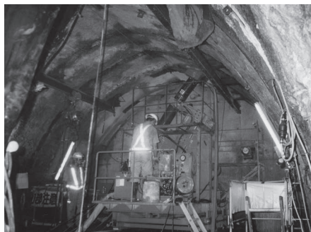
写真－7 曲線ボーリング施工中
