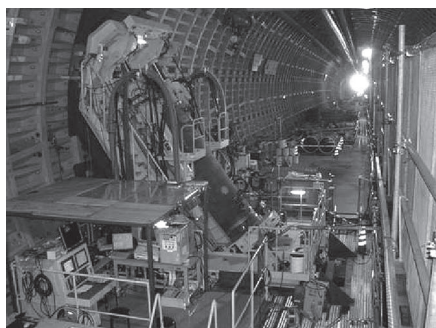
写真－17 曲線パイプルーフ掘進
