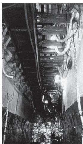
写真-5 掘削完了
