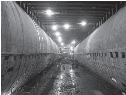
写真-20 シールドトンネル間掘削完了
