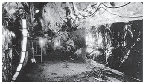
写真-4 掘削全景
