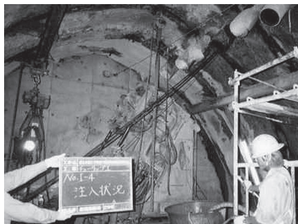
写真－8 薬液注入工
