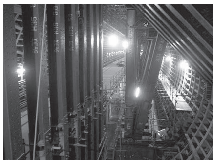
写真－19 シールドトンネル内部支保工
