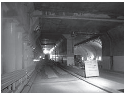
写真-22 躯体構築全景
