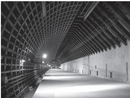
写真-21 躯体構築状況
