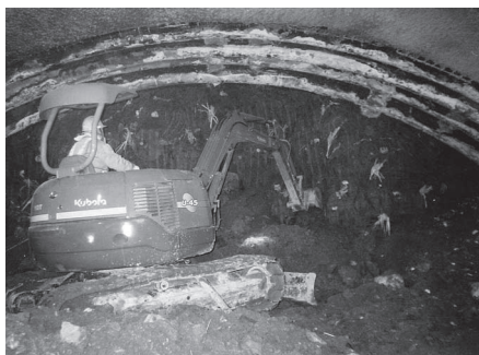
写真-9 本坑上半掘削
