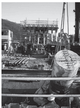
写真－15 実証実験状況（推進機到達）
