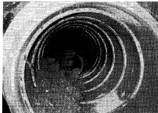
写真-8 既設管がケーシングロッドのスパイラルの働きにより排出されている状況
