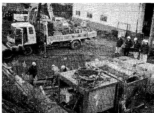
写真-1 作業状況
