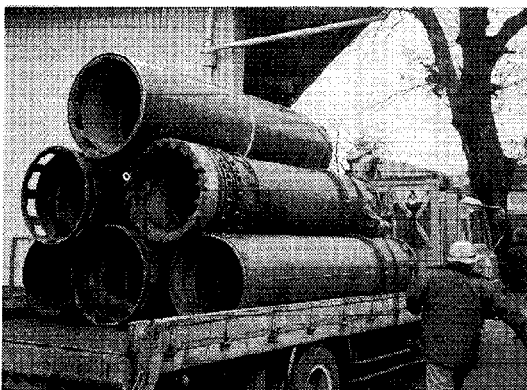
写真-6 ビット回転と排土に供するケーシングロッド
