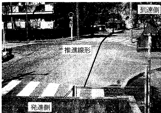
写真-4 ②スパン現場状況
