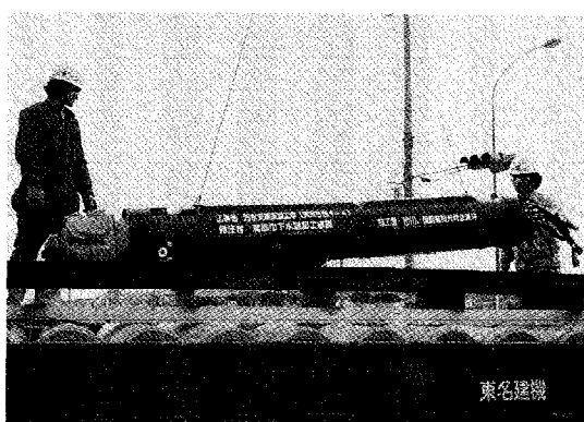
写真-7 先導体全景
