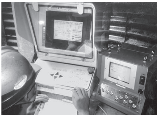
写真13 現場での操作状況(三興建設)
