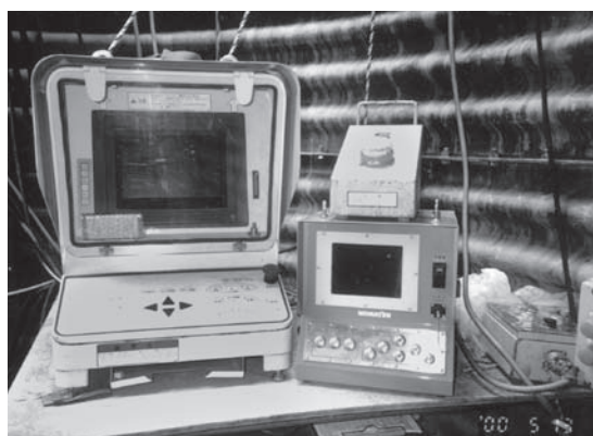
写真一七 データ収集ユニット設置状況
