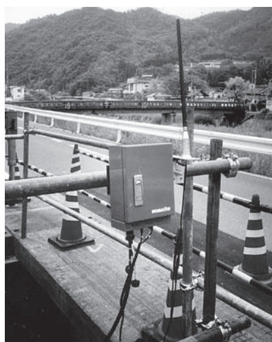
写真一八 通信ユニット設置状況
