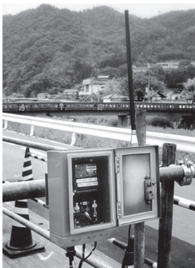
写真一五 通信ユニットに設置された携帯電話
