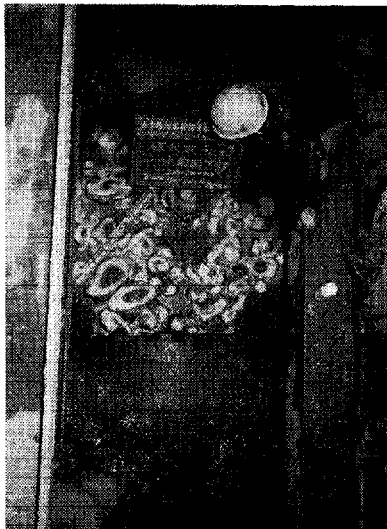
写真-2 トラブル例(2) 掘削断面に予想以上の礫数、巨礫が出た。
