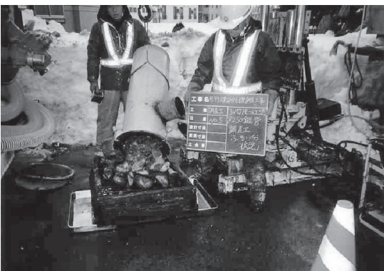
写真-6 土砂採取(ふるい器具)
