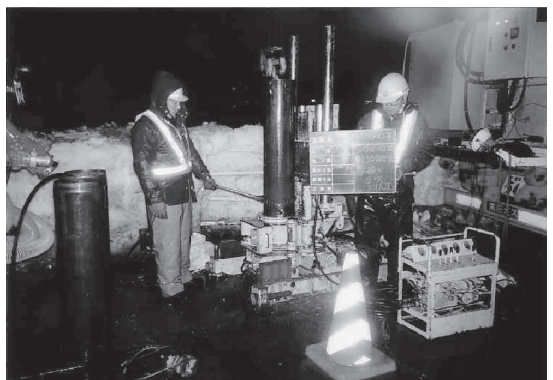
写真-7 ケーシングパイプ引抜き
