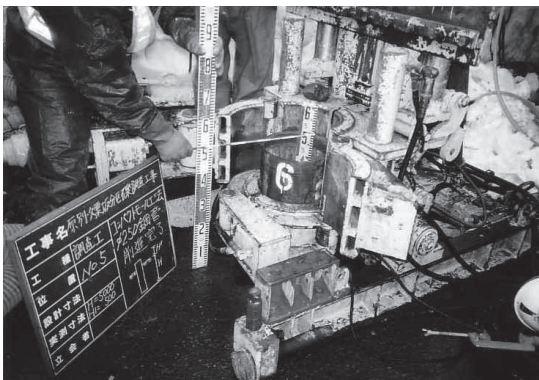
写真-4 ケーシングパイプ建て込み
