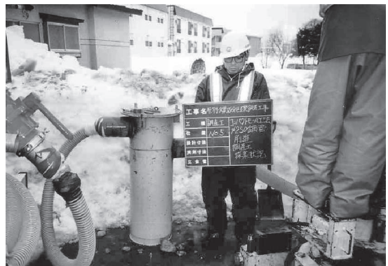
写真-5 土砂と水を分離
