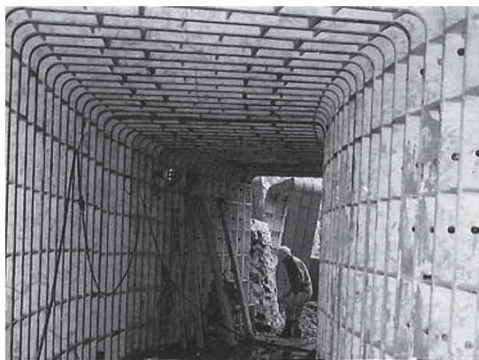
写真三 混合推進（曲線部）
