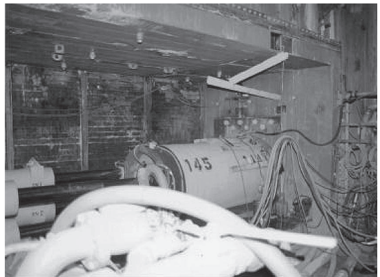
写真－６ ステーション内推進状況
