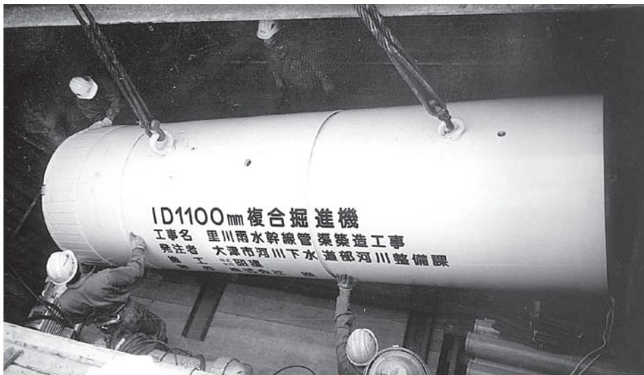
写真－１ シールド機搬入状況
