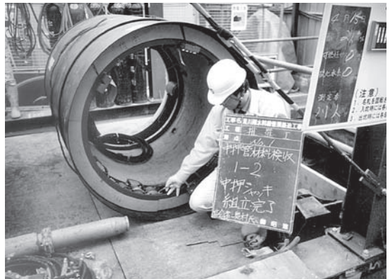
写真－3.1 曲進中押し
