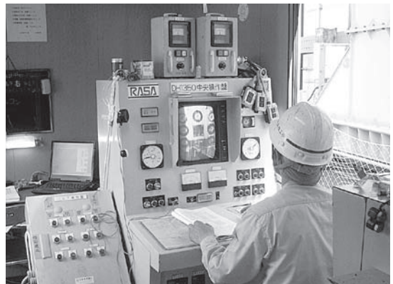
写真一〇 遠隔操作による掘進機の操作
