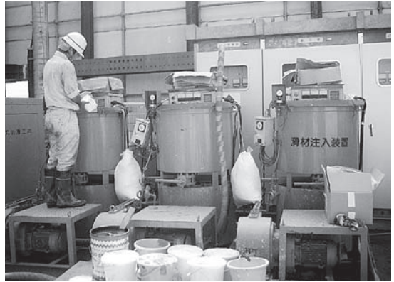
写真一八 複数の注入装置により滑材を注入
