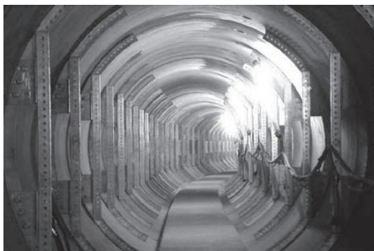
写真-5 洞道内状況（推進部）
