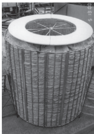
写真ー2 被膜格納状況
