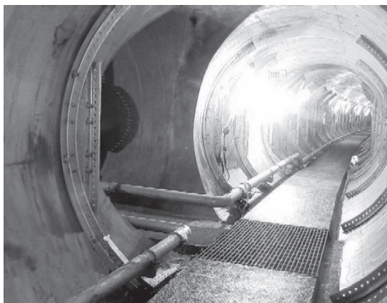
写真一8 地中接続部坑内状況
