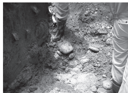
写真-8 破損させた礫地盤状況
