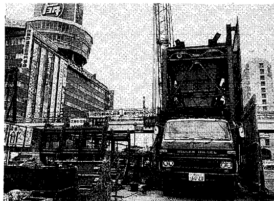
写真-7 ホッパーによりトラックに土砂を積み込む
