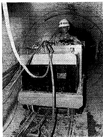
写真-3 バッテリーカーによる土砂運搬
