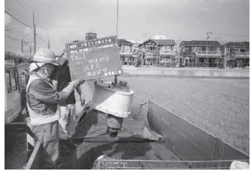
写真-14 ギャボックス回収状況
