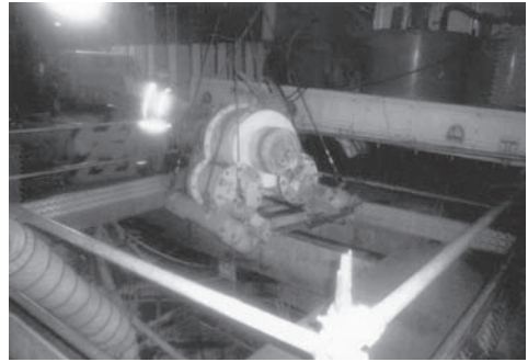
写真-22 ギヤボックス搬出
