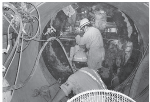
写真-24 BH杭撤去
