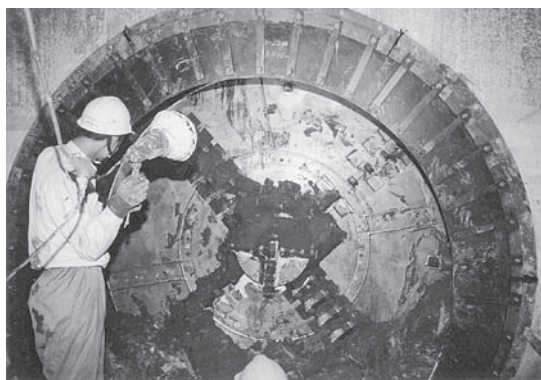
写真－4 φ2200泥水式マシン到達状況
