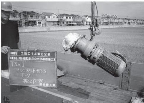
写真-13 減速機回収状況
