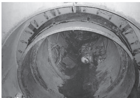
写真-26 掘進機分解完了
