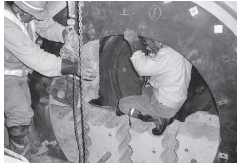
写真-23 コア抜き撤去
