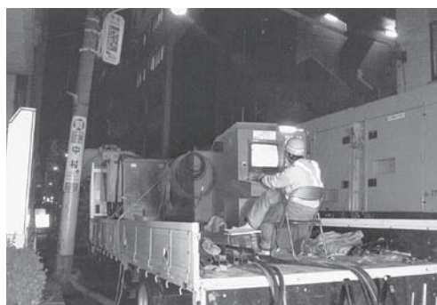
写真-16 車上プラント運転操作中
