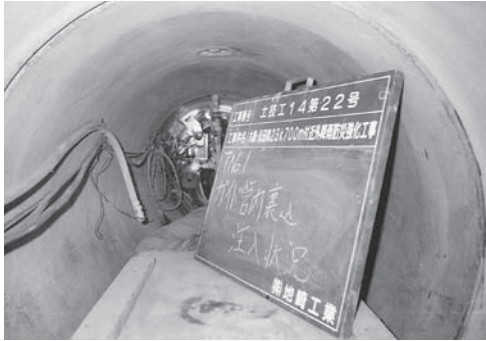
写真-11 ガイド管裏込注入
