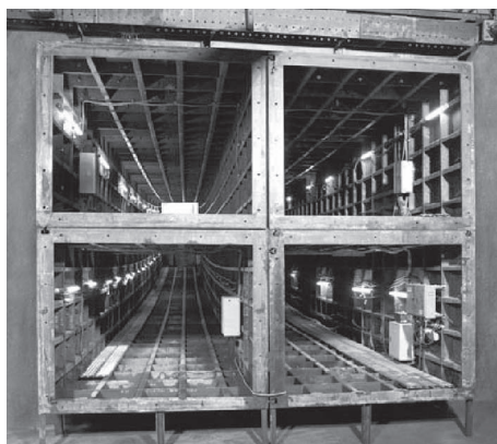
写真－4 地下通路③掘削完了
