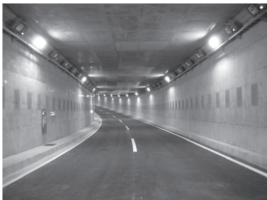
写真一10 国道1号原宿立体工事（その1） トンネル完成写真
