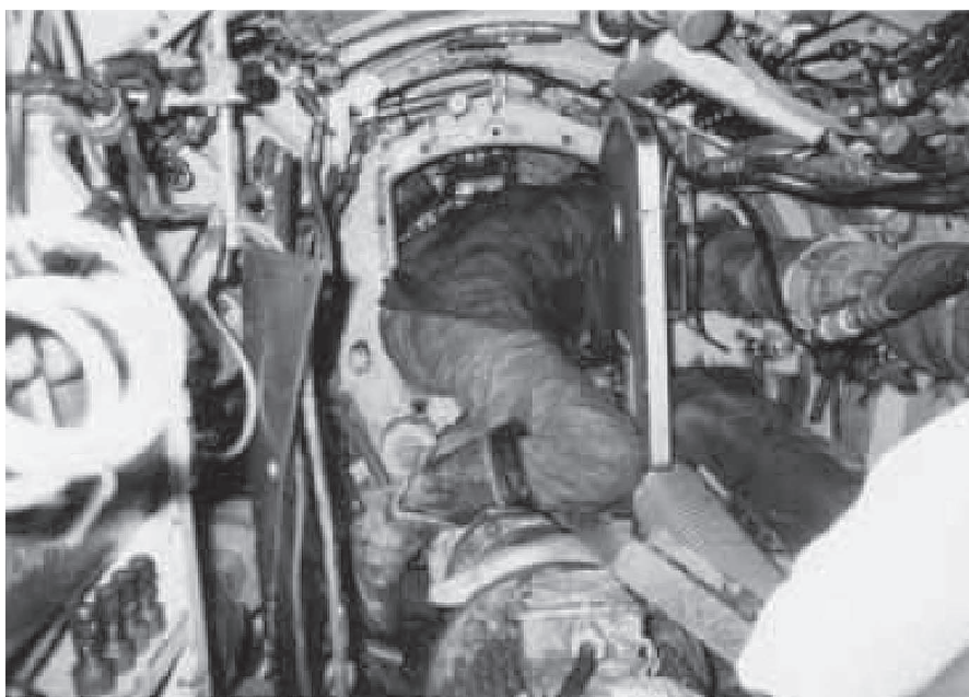
写真-6 機内からビット交換
