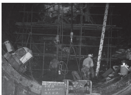
写真一八 接続部シールド解体工
