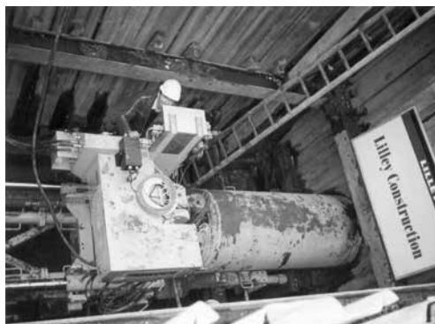
▲ 施工概要：英国（1989年）、ホリゾンガー工法、施工延長2km、 \phi 700 コンクリート管（写真提供：三和機材㈱）
