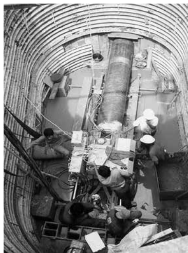
▲ 施工概要：インドネシア（1990～2004年）、ホリゾンガー工法、施工延長15km、 \phi 450～600 コンクリート管（写真提供：三和機材㈱）
