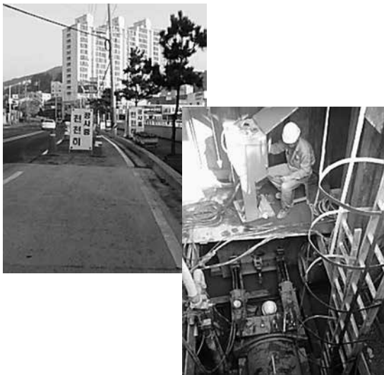
写真-1 韓国の施工状況
