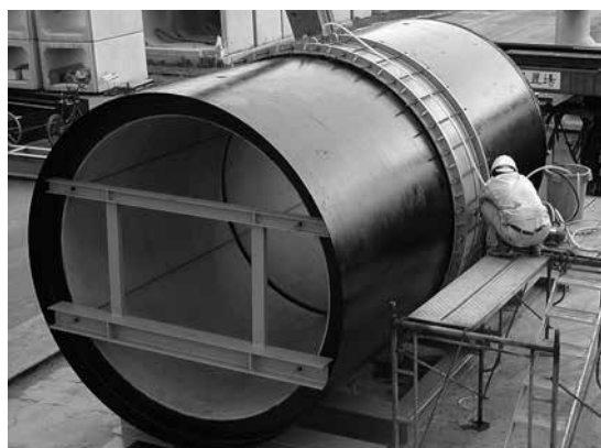
写真－2 合成鋼管耐水圧試験状況
