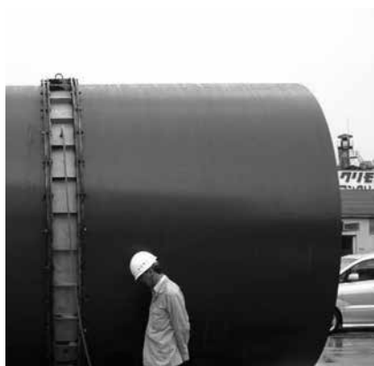
写真－4 MAX推進管耐水圧試験状況
