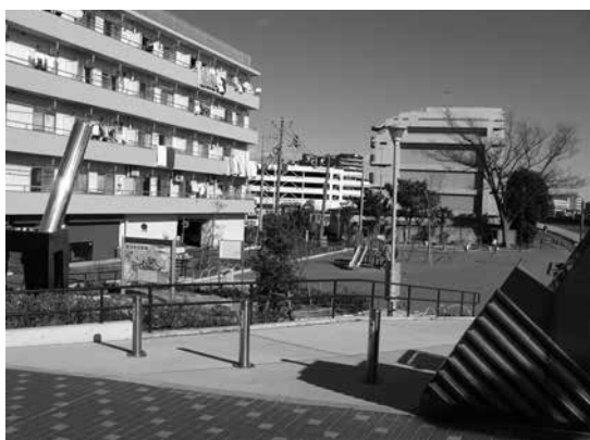
写真ー1 施工箇所状況（竣工後）
