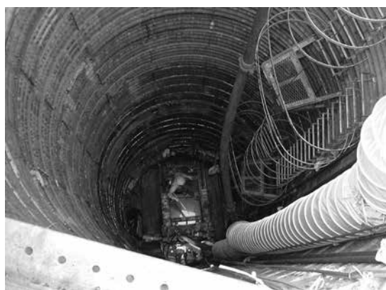
写真－２ 施工現場状況（発進立坑）
