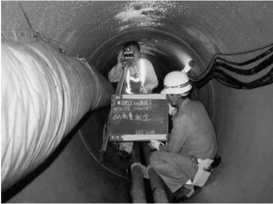
写真－1 推進測量の状況
