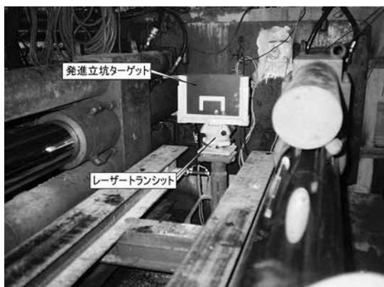
写真-2 発進立坑内ターゲット
