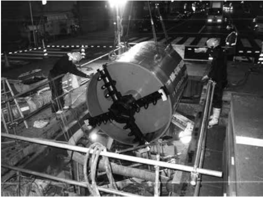
写真－1 推進機吊り下し状況
