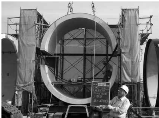
写真－1 超大口径管推進工法
