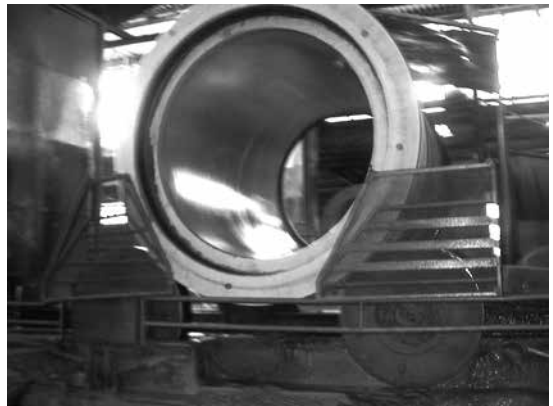
写真-4 遠心締め固め状況
