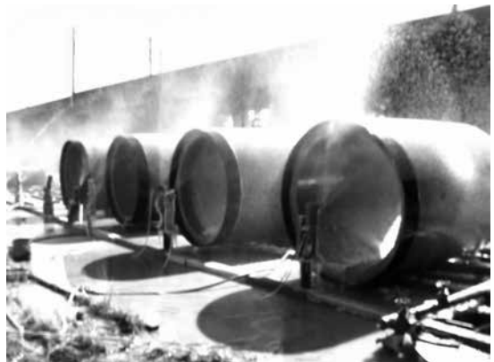
写真-5 散水養生状況
