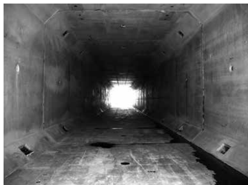
写真－1 本工法にて構築された地下空間（雨水渠）
