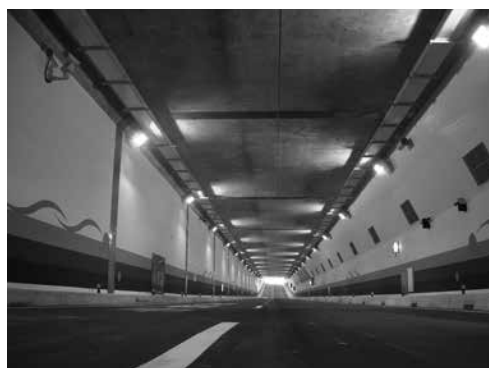
写真－2 ESA工法（幅22.2m×高さ7.8m×長さ100.0m）
