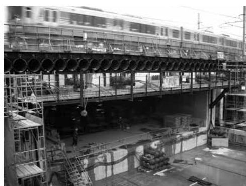
写真－1 FJ工法（幅21.6m×高さ7.9m×長さ16.8m）
