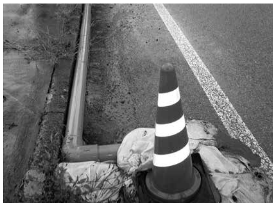
写真－１ 応急復旧 地上配管（下の写真は人孔箇所地中配管）
