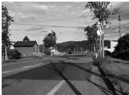
写真－２ 応急復旧 人孔部段差解消
