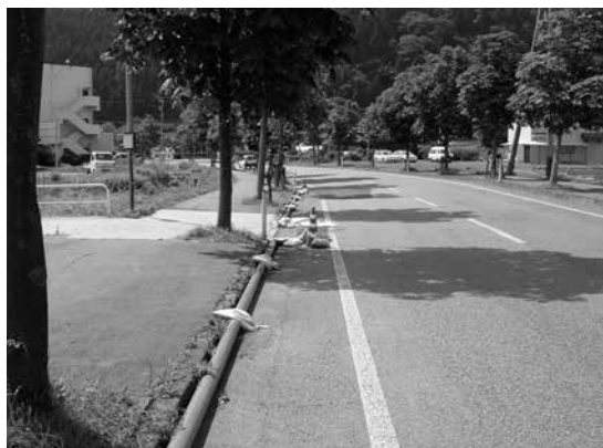
写真－１ 応急復旧 地上配管（下の写真は人孔箇所地中配管）
