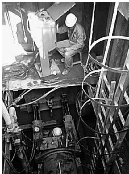
写真八 코브라工法發進立坑内 (韓国百濟)
