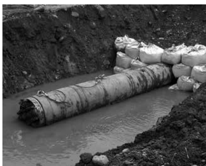
写真四 エスエスモール到達状況 (台湾花蓮市)
