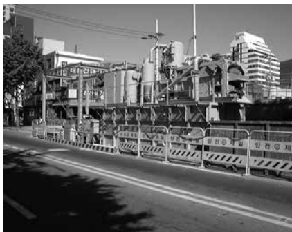
写真一 サクセスモール工法地上プラント (釜山)
