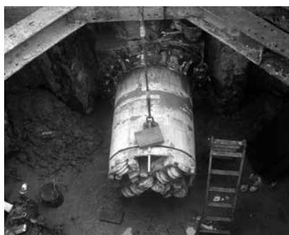
写真五 エスエスモール到達状況 (韓国仁川)
