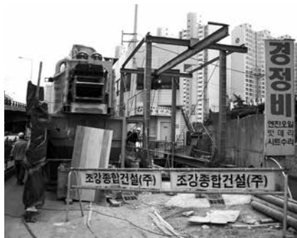
写真二 サクセスモール工法現場風景 (釜山)
