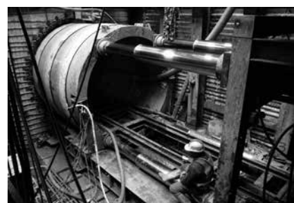
写真-2 元押ジャッキ上下配置
