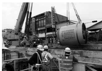
写真-1 掘進機吊降
