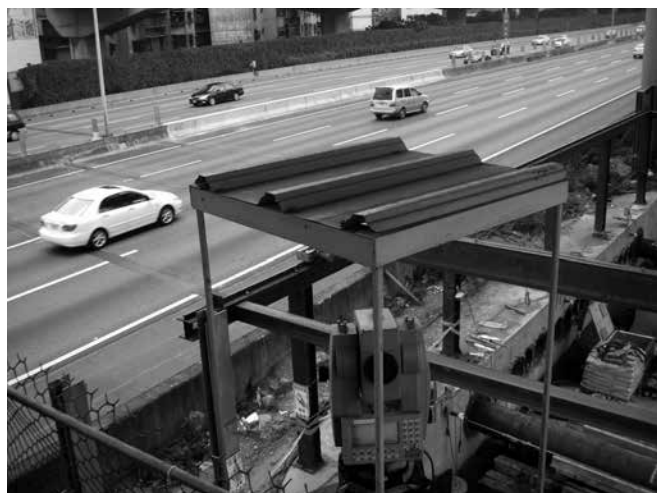
写真-1 三重自動沈下計測設置
