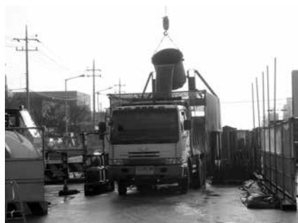
写真－1 現場作業風景
