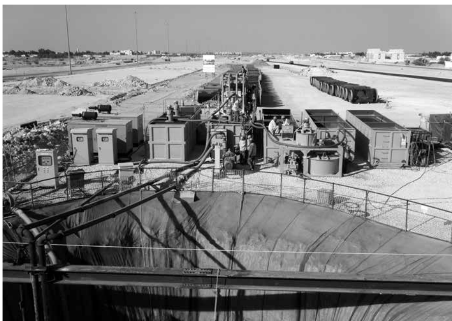
写真-1 現場風景
