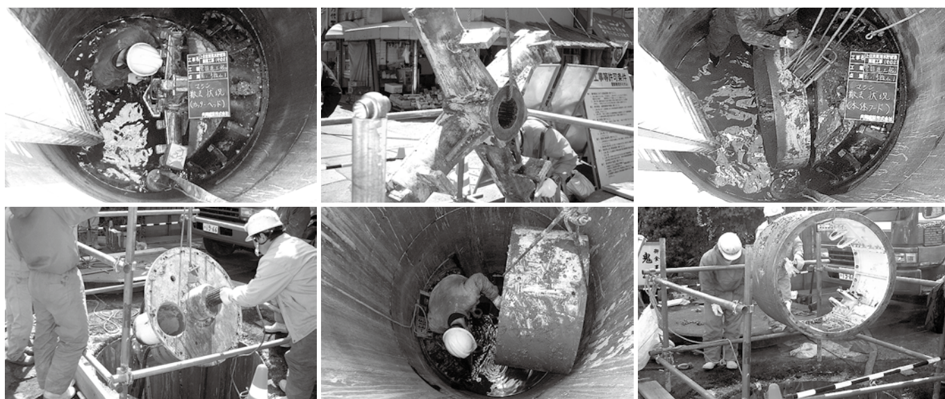
写真-1 呼び径800 φ1500mmケーシング 最小分割回収
