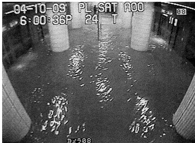
写真－2 東京メトロ南北線麻布十番駅の浸水被害の例 (平成16年10月9日) 台風22号
