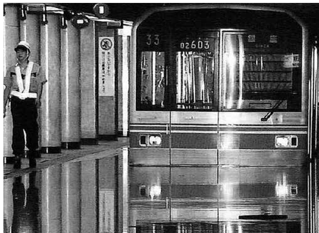
写真－1 東京メトロ丸の内線赤坂見附駅の浸水被害の例 (平成5年8月27日) 台風11号
