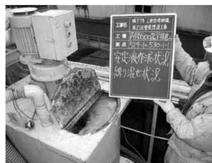
写真-5 作泥材の調整
