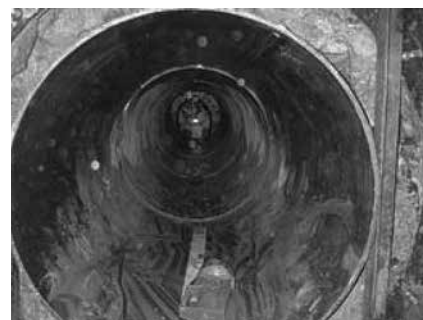
写真-3 先導体の回収
