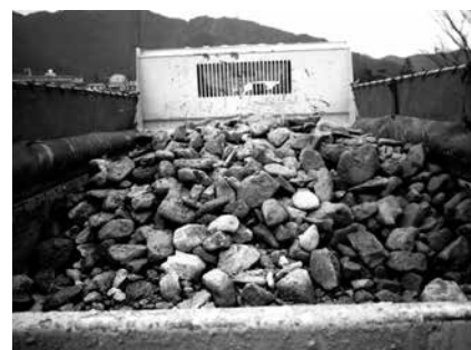
写真-4 管内排土した礫。礫率の多さに驚く
