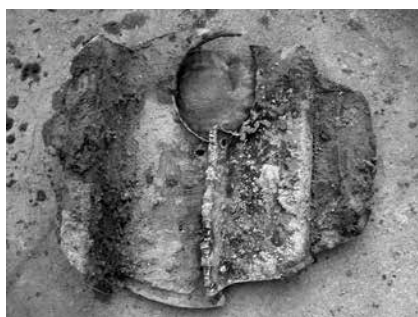
写真-2 撤去した鋼矢板の一部
