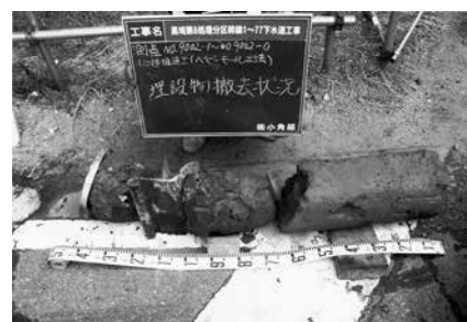
写真2 埋設物切断
